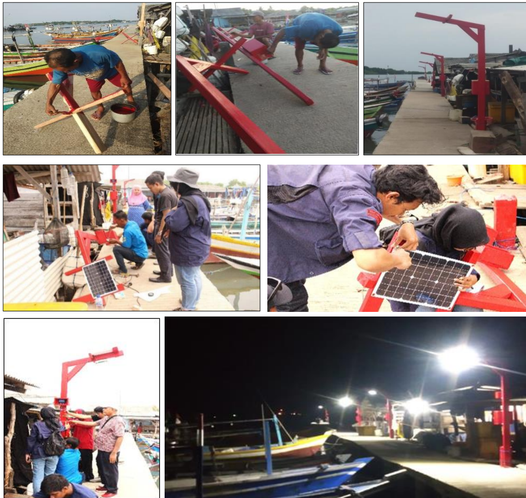
Gambar 7. Pelatihan memasang tiang lampu penerangan dan komponen panel solar cell
